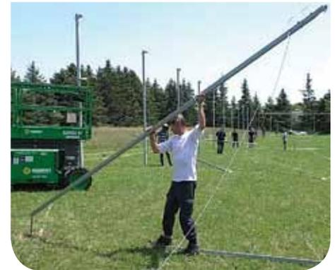
Los postes interiores están diseñados para erguirse sobre anclas con barreno o bases (pre-postes). Los postes de las esquinas y los cables de refuerzo en los extremos deben colocarse en concreto u hormigón.
