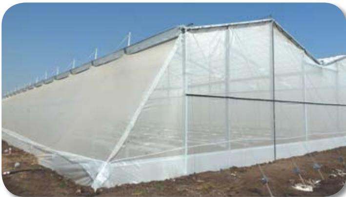
Si las temperaturas por la noche en invierno son muy bajas y los veranos son muy calurosos y secos, cubrir las paredes con cubierta fija blanca o cubierta de plástico transparente
