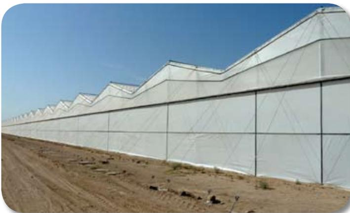
Instalar cubierta blanca de reducción de temperatura para proteger los cultivos de una radiación excesiva en las paredes Este y Oeste, y posiblemente en las paredes laterales Norte y Sur, si la radiación es alta y la humedad tiende a ser baja.
