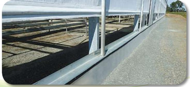
Elegir puerta corredera estandar o una puerta a medida más ancha. Un travesaño puede ser instalado bajo la canaleta en el pasillo si se requieren pasillos más anchos.
