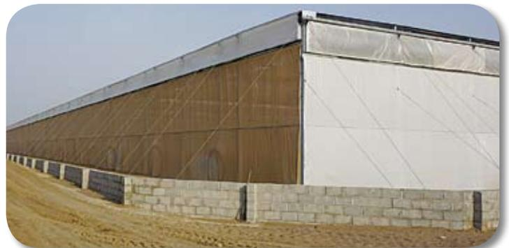
Cubrir las paredes perimetrales con cortinas motorizadas si los cultivos se pueden beneficiar del viento, siempre que pueda secar el suelo después de la lluvia, o si el invernadero se podría ver afectado por un huracán o ciclón.
