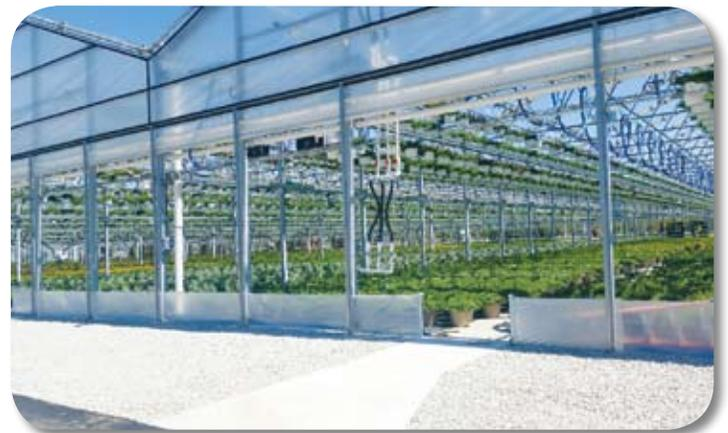
Las cortinas laterales son movidas por motores que se deslizan sobre una barra guía y están equilibradas con unas pesas.
